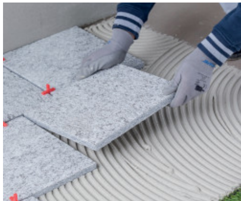
Buitenshuis aanbrengen van natuursteen
