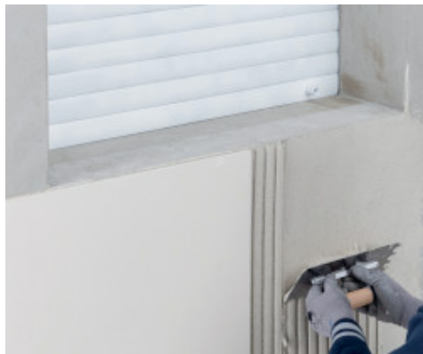
Aanbrengen van groot-formaat keramische tegels
